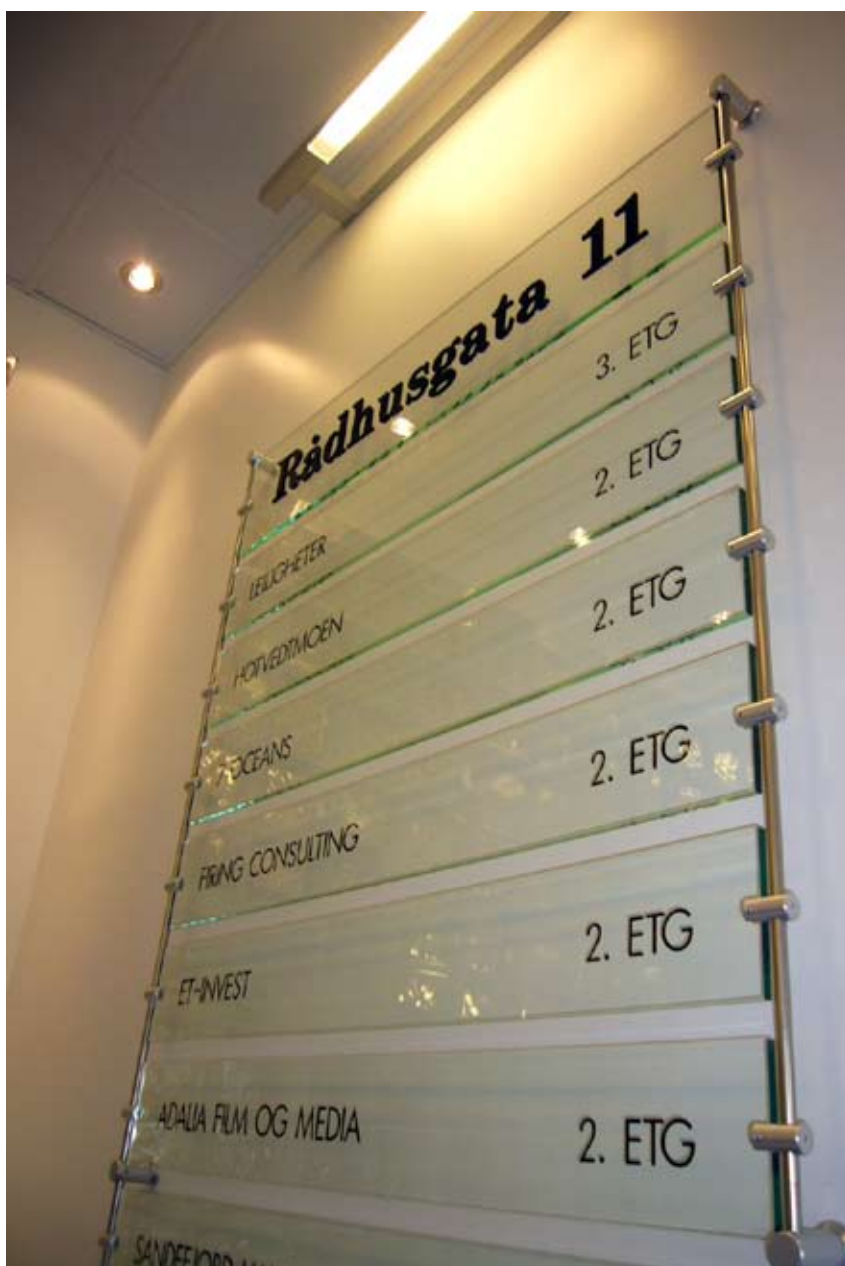
Fleksibel leietakeroversikt montert i et rodsystem. Lamellene i systemet er laget i plexiglass glasslook med foliedekor. Gateadressen er laget i laserskåret sort, gjennomfarget plexiglass med strøkne kanter.
