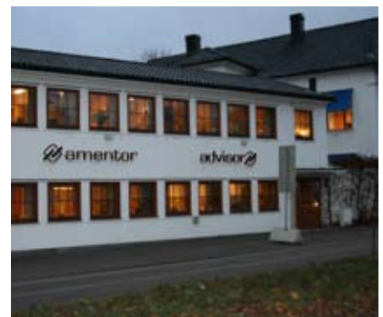
Fasadelogoer i sortlakkert aluminium. LED diodelys som lyser bakover.
