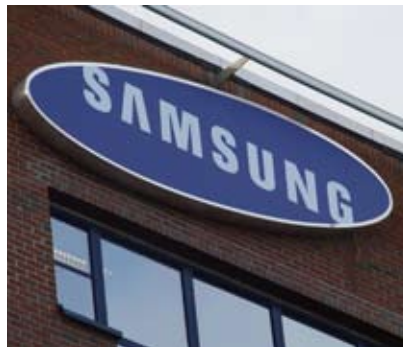
Fasadelogo med innvendig lys. Fronten er trykket i ett stykke på duk og strammet opp på den ovale lyskassen. Skiltet er 495 cm langt og 165 cm høyt.
