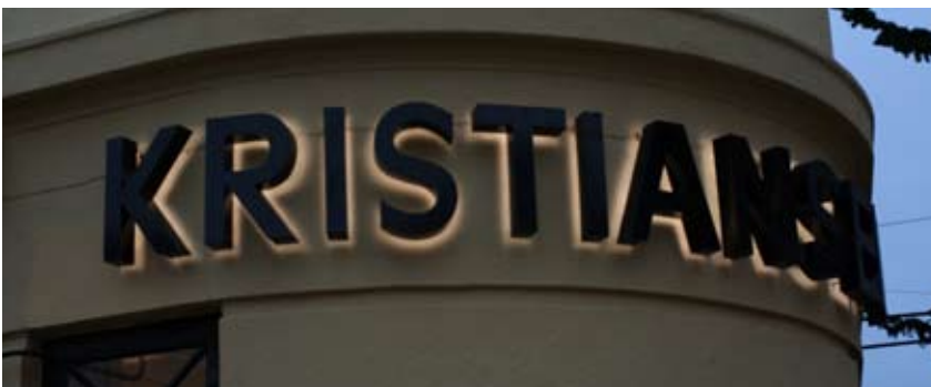
Kombinasjon av fasadebokstaver. «Kristiansen» i aluminiumsbokstaver med LED diodelys bakover montert på buet hjørne på fasaden. «Optiker», «Gullsmed» og «Urmaker» i fasadebokstaver i aluminium med indirekte belysning fra spotlights på arm.
