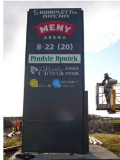
Spesialprodusert skiltsøyle produsert i moduler. Modulene er produsert i pulverlakkert aluminium med utfroste logoer. Det er montert innvendig lys i hver modul. Søylene er L-formet og har to like eksponeringssider p.g.a. trafikkbildet på plassen. Hele søylen er 6 meter høy og 150 cm bred.
