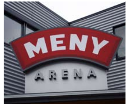
Fasadelogo med innvendig lys. Fronten er trykket i ett stykke på duk. «Arena» er laget som fasadebokstaver med LED diodelys som lyser fremover.
