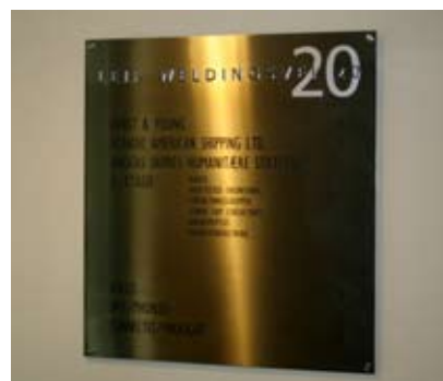
Leietakeroversikt i børstet, rustfritt stål med avstandsstykker i børstet, rustfritt stål. Gateadressen er laget i laserskåret plexiglass. Øvrig dekor i utskåret folie.
