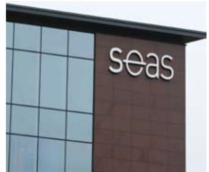
Fasadelogo i lakkert aluminium med front i børstet aluminium. LED diodelys bakover. Logoen er 4 meter lang og 1 meter høy.
