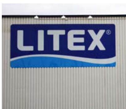
Fasadelogo montert i folie på hvite aluminiums-plater. Indirekte belysning med spotlights.
