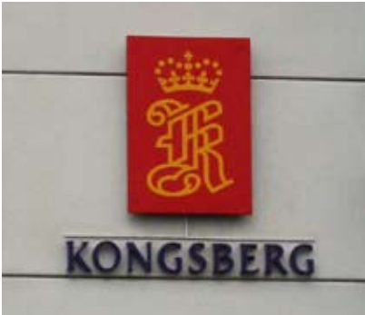
«Kongsberg»-logo med LED diodelys som lyser fremover i skrift og symbol i tillegg til bakover rundt rektangelet.
